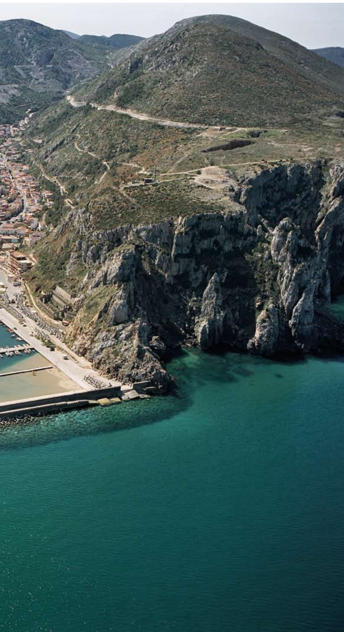
Insediamiento minerario di Buggerru (CI) disposto lungo il compluvio di monte Malfidano e Cuccuru Trebini. (ph. Gianni Alvito - TERAVIDA).
