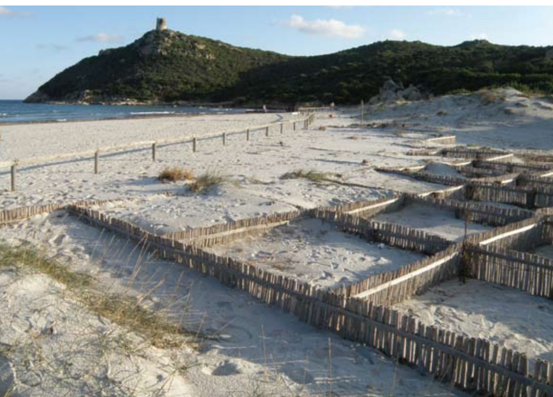
Mitigazione dell'erosione costiera attraverso l'installazione di scacchiere frangivento per l'intrappolamento delle sabbie e la ricostruzione dei sistemi dunari nel litorale di Villasimius (CA). (Foto Criteria).
